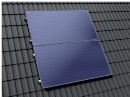
Montaż na dachu skośnym
